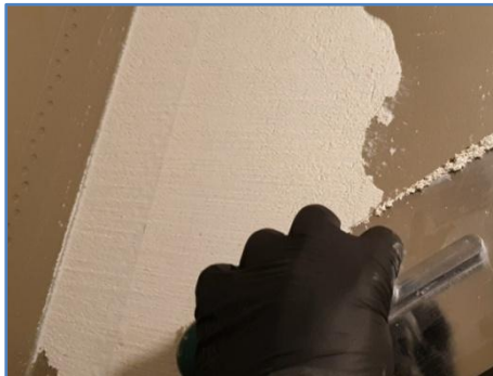
Przykład aplikacji na hydroizolacji z taśmami
