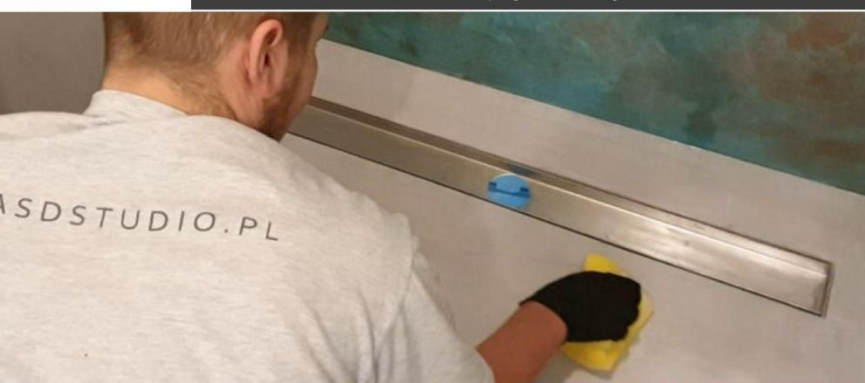
Jedna warstwa impregnatu i ewentualne usunięcie drobnej szorstkości jeśli taka wystąpiła. Następnie dwukrotnie lakierujemy całą łazienkę, a po wyschnięciu lakieru, minimum po 48h aplikujemy silikon.
