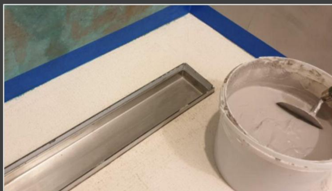
Po wykonaniu wszystkich warstw mikrocementu na ścianach, aplikacja dwóch warstw MEDIUM FAST
