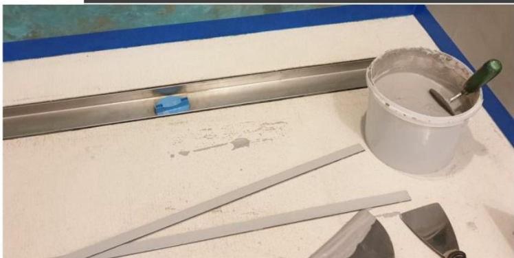
Po wykonaniu wszystkich warstw mikrocementu na ścianach, aplikacja dwóch warstw MEDIUM FAST
