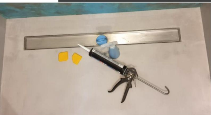
Jedna warstwa impregnatu i ewentualne usunięcie drobnej szorstkości jeśli taka wystąpiła. Następnie dwukrotnie lakierujemy całą łazienkę, a po wyschnięciu lakieru, minimum po 48h aplikujemy silikon.
