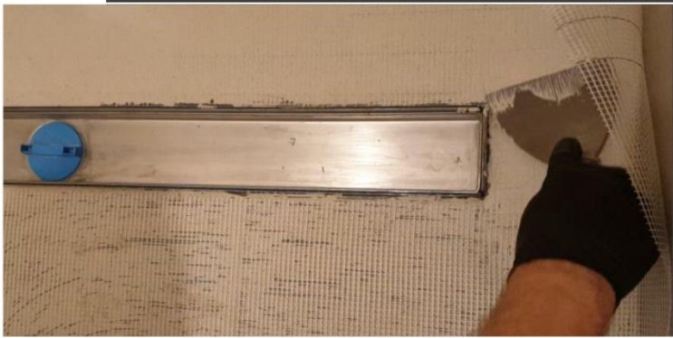
Elastic + Resina + siatka, aplikacja na zagruntowane wcześniej podłoże z hydroizolacji.
