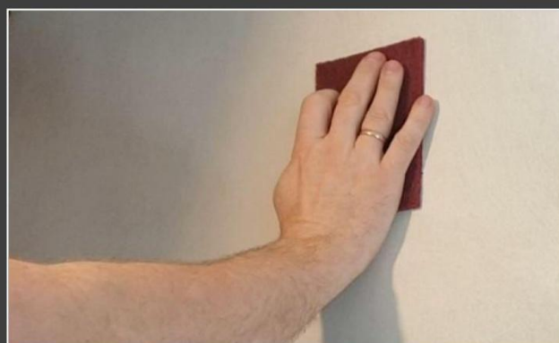
Jedna warstwa impregnatu i ewentualne usunięcie drobnej szorstkości jeśli taka wystąpiła. Następnie dwukrotnie lakierujemy całą łazienkę, a po wyschnięciu lakieru, minimum po 48h aplikujemy silikon.
