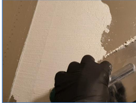
Przykład aplikacji na hydroizolacji z taśmami
